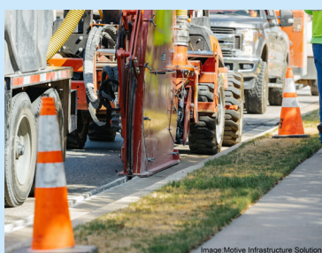
Corte de una zanja para el conducto de fibra.
